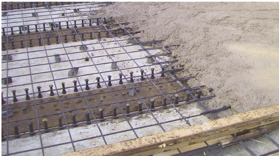
Obr. 6 Aplikace spřahovacích šroubů TCB
